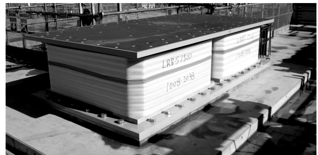
図8 免震装置設置状況
