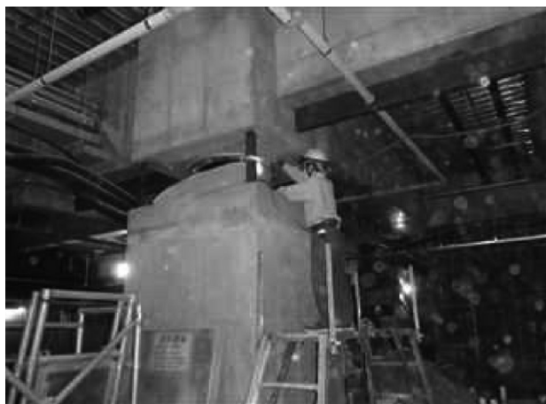
写真2 免震装置取付け状況
