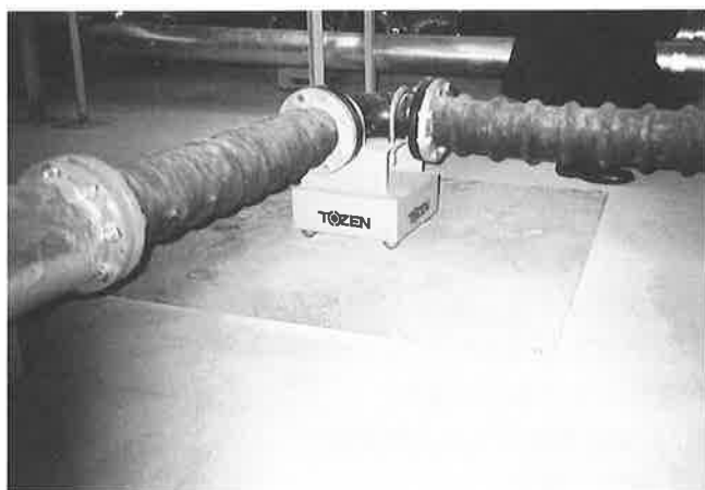
写真-3 給水管可撓継手
