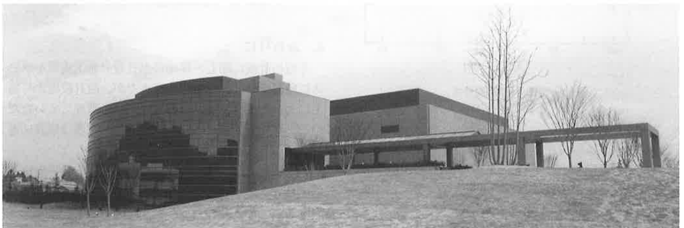
写真一1 建物全景
