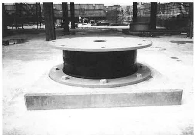
写真一5 免震装置設置状況 (H7. 4月中)
