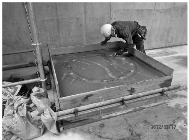
写真4 免震基礎の施工状況
