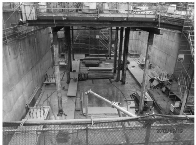
写真3 免震層の施工状況
