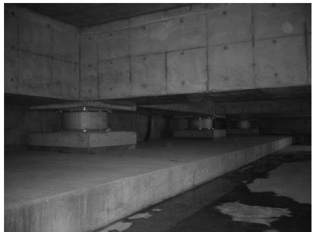
写真2 免震層の状況
