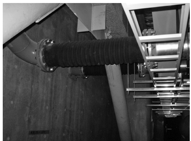
写真1 設備配管の取付状況
