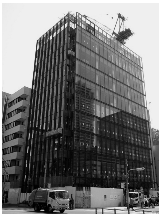
写真8 訪問時の建物外観
