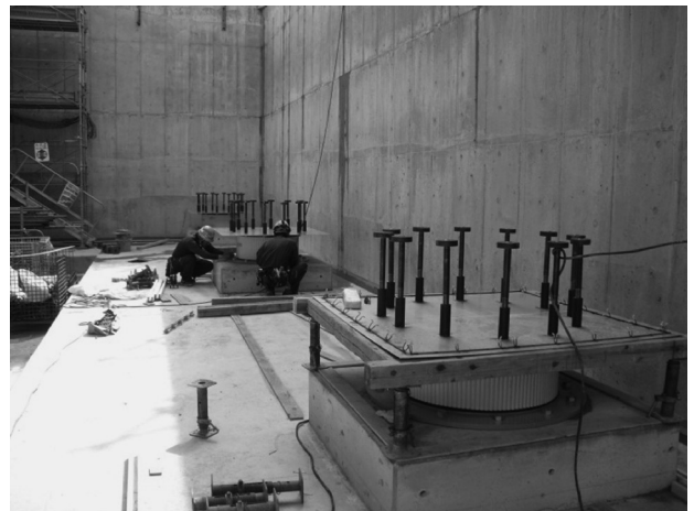
写真5 免震積層ゴムの設置状況
