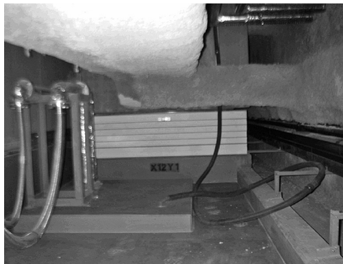
写真6 耐火被覆が施工された積層ゴム
