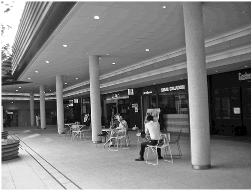
写真9 地下広場のφ400円形細柱 (300N/mm 2 )
