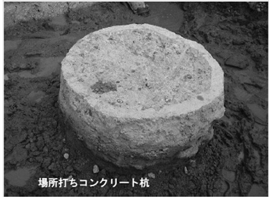
写真8 既存杭の調査状況
