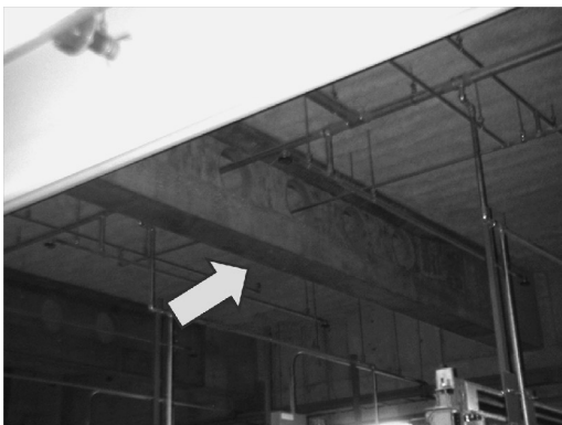
写真10 B2地下駐車場から見たT-POP梁床梁
