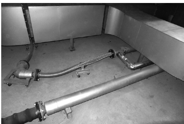
写真12 設備配管類の伸縮継手
