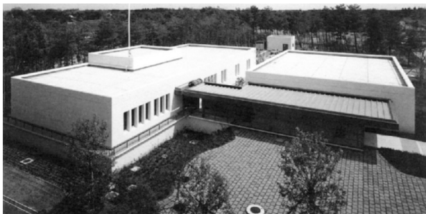
写真1 無振動特殊実験棟の全景（左：免震建物 右：耐震建物） （MENSIN NO.16より）
