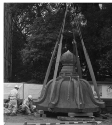
写真3 笠石の撤去時の状況
