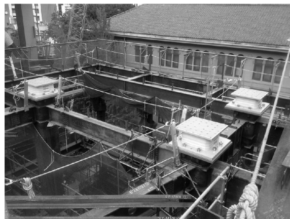
図27 免震装置の設置
