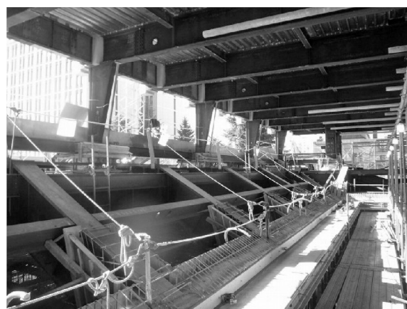
図28 高層棟柱の設置
