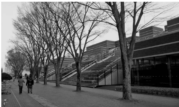
写真1 北側通路からの建物外観
