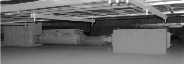
写真7 オイルダンパー
