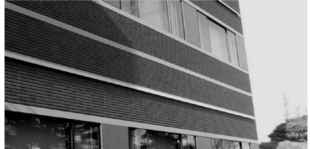
写真4 建物外壁のボーダー
