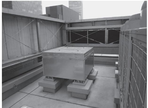
写真2 屋上に設置したTMD
