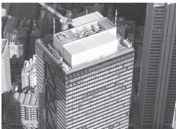
写真5 TMD設置工事中の状況
