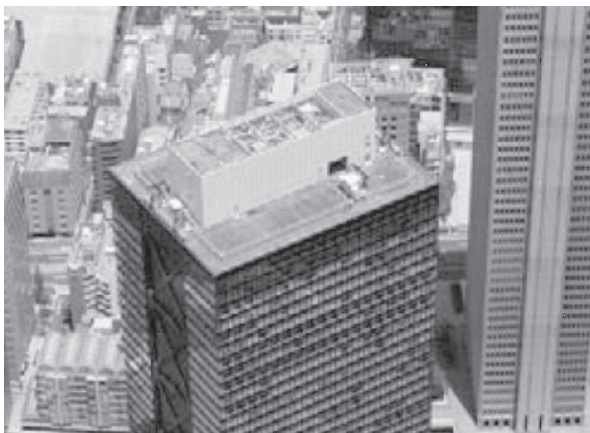
写真4 TMD設置前の屋上の状況
