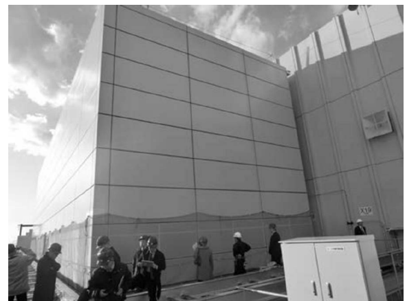
写真8 TMD置場外観
