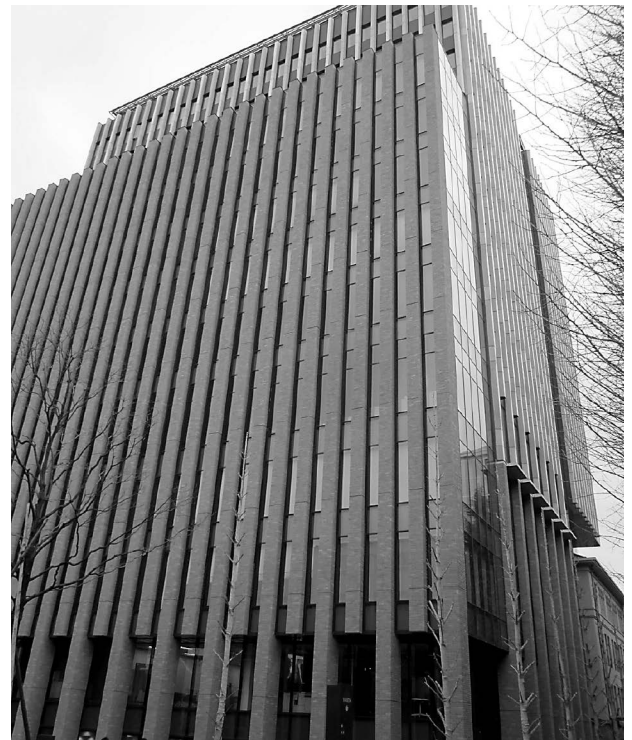
写真5 「高層棟」外観 (下階通し柱が本体SRC)
