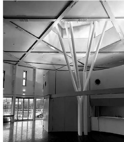
写真2 鉄骨部屋根及びY型柱
