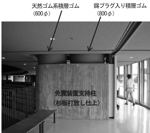
写真5 免震装置設置状況
