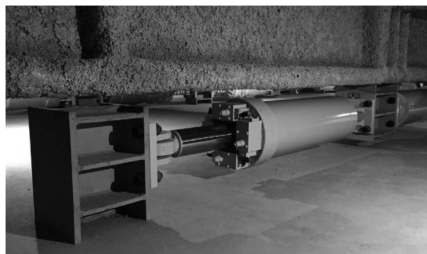
図12 ロック機構付オイルダンパー
