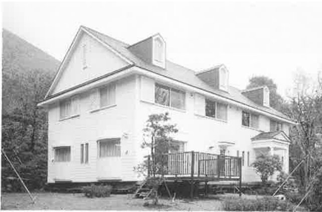
写真-1 建物全景
