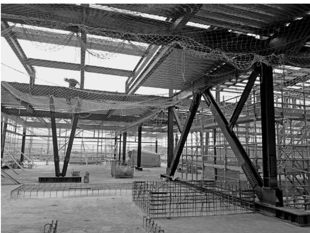
写真3.3 4階鉄骨ブレース
