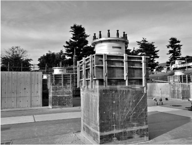
写真3.1 免震装置の設置状況
