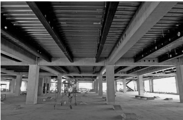
写真3.2 PCaPCラーメン架構と鉄骨小梁
