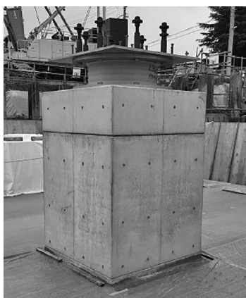
図9 柱頭部免震部材据付後
