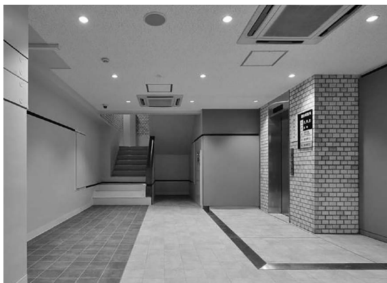
写真7 免震エキスパンションジョイント
