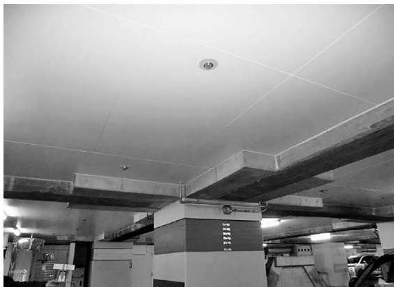
写真3 柱上部の積層ゴムの設置状況
