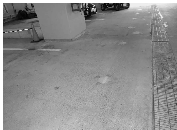
写真6 高圧噴射攪拌工法の床開口の跡
