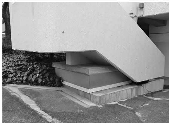
写真4 外階段部分のすべり支承の設置状況
