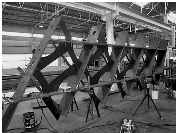
写真5 工場での製作状況
