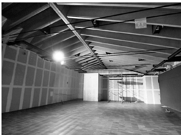
写真3 工事中の展示室
