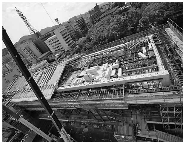
写真2 PCaPC版の建て方
