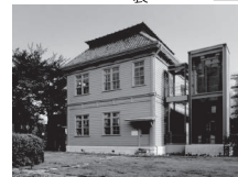
製粉ミュージアム本館
