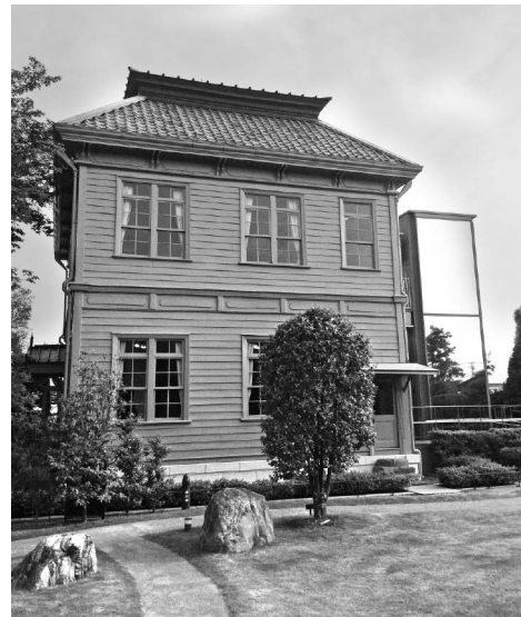
写真1 建物外観 (本館)
