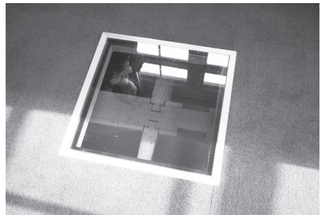
写真4 旧部材の見える化 (2階床組)
