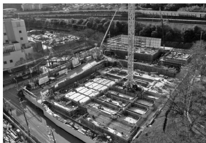
1階RC梁の施工状況
