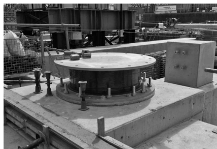
積層ゴム支承の設置
