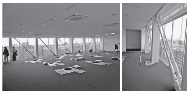
写真3 大トラス内観 (左：全景、右：ツインタイロッド)
