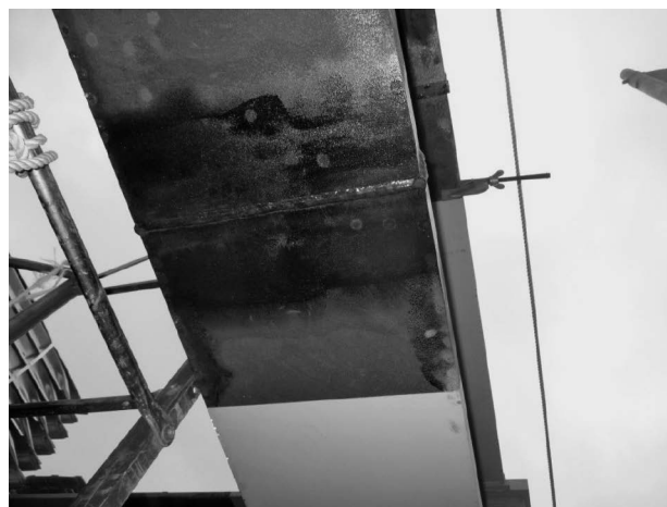
写真12 下フランジ溶接状況
