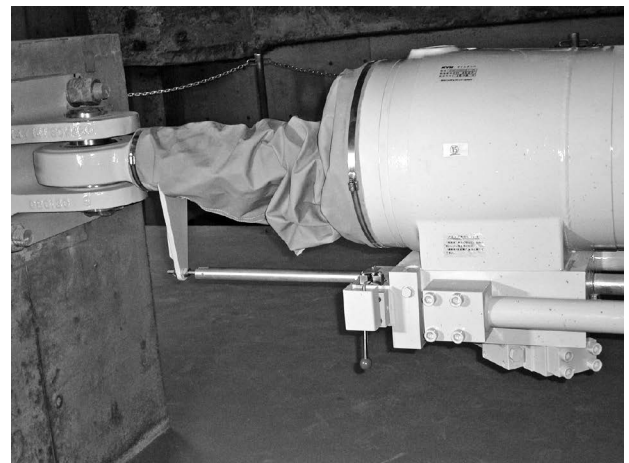
写真3 切替部 (下部レバーは手動切替用)
