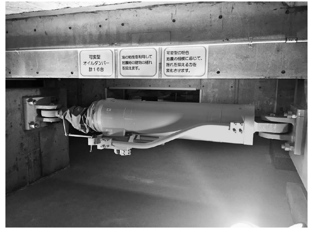
写真2 パッシブ切替型ダンパー
