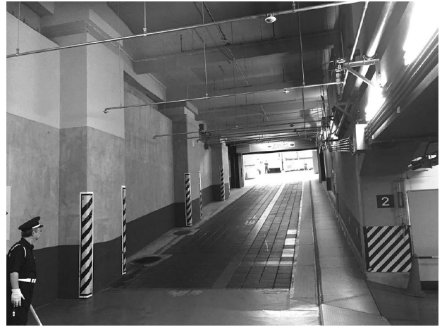
写真7 隣地側建物内部（車路）
