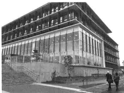
写真2 建物西面から見える擁壁
