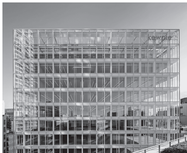
写真3 正面ファサード
