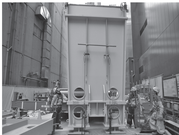
写真3 通し壁柱の建方状況
