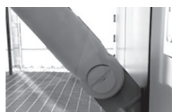
写真2 ブレース端部
