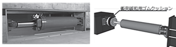
図5 パッシブロックダンパー (左) と衝突緩和機構付きオイルダンパー (右)
