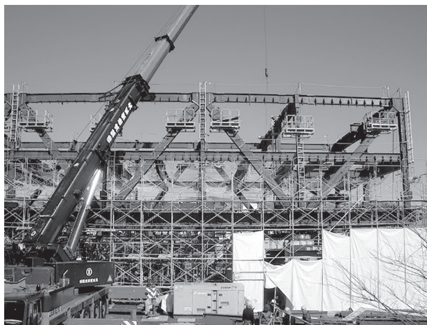
図14 鉄骨架構施工状況
