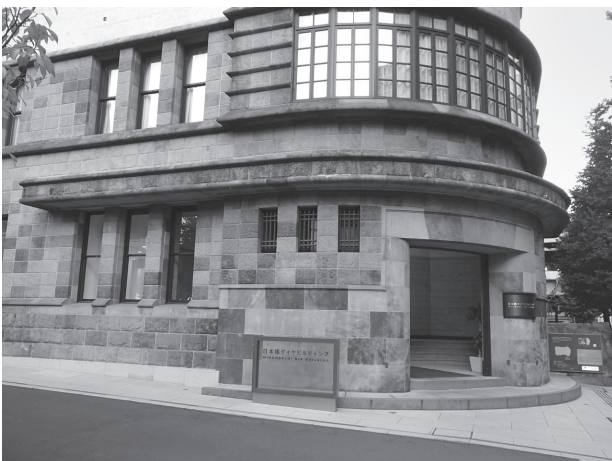
写真10 既存建物部外観2
