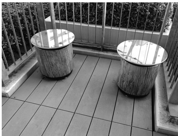
写真7 下部構造の屋上部3
