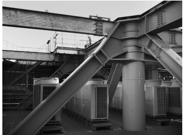
写真2 メガトラス形式の架構（屋上）
