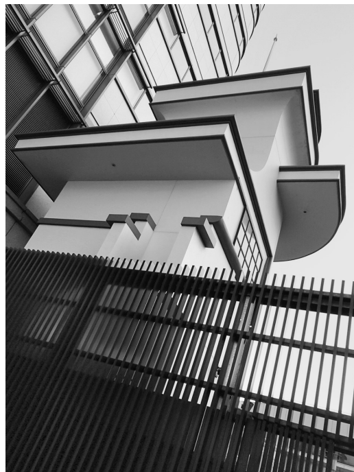
写真6 下部構造の屋上部2
