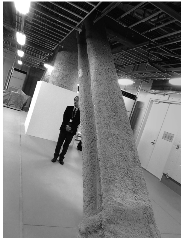
写真3 メガトラス形式の架構（免震層上階）
