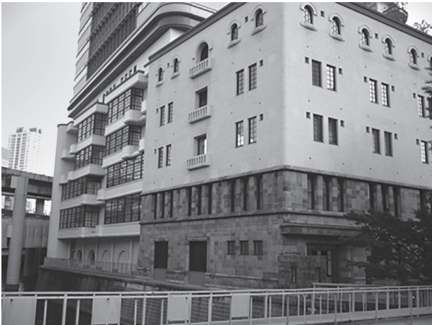
写真9 既存建物部外観1
