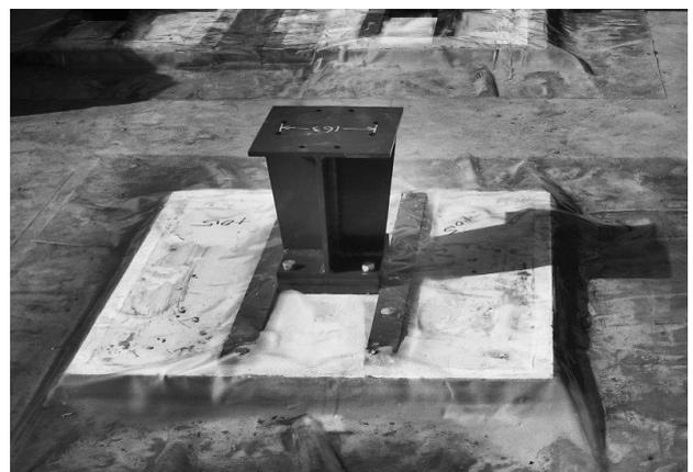
写真2 すべり支承 (上部鉄骨束材)
