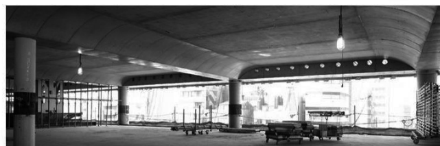
CFT 柱と SRC 大梁および一方向スラブ躯体（撮影：日建設計）
