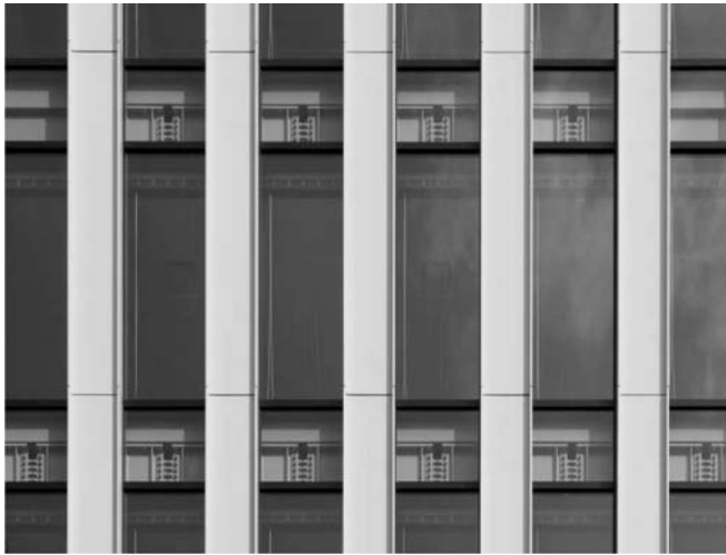
制震外装外観（撮影：(株)エスエス東京）
