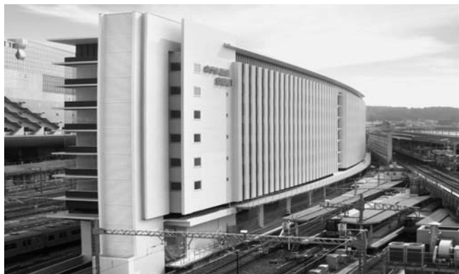
建物外観（西面）
