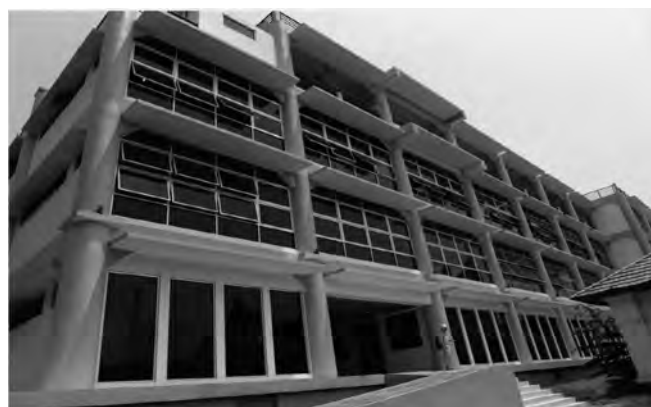
設計協力したインドネシア・スマトラ島・パダンの基礎免震建物 (手前のスロープは建物に接しているため、切り離しを要請してきた。)
