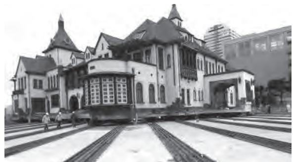
旧李王家曳家の状況
