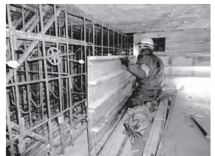
ピット内での梁補強作業
