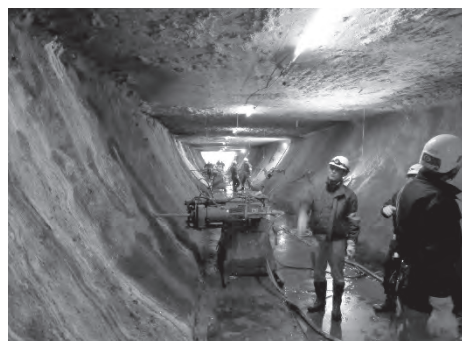
トンネル法面へのコンクリート吹付と薬液注入
