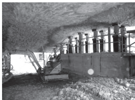
建物支持地盤の全掘削
