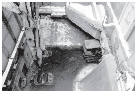
ミニコンボによる建物下掘削
