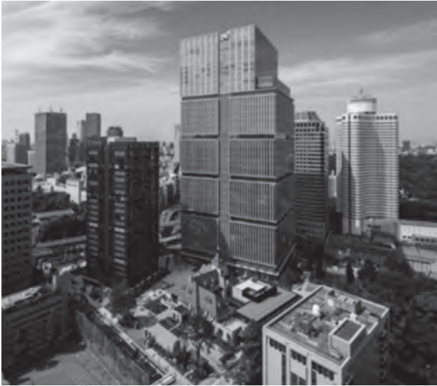
建物外観（北東側）
