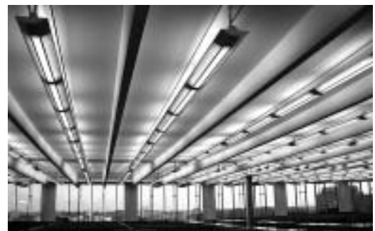
執務室内観（PC構造の天井と間接照明）
