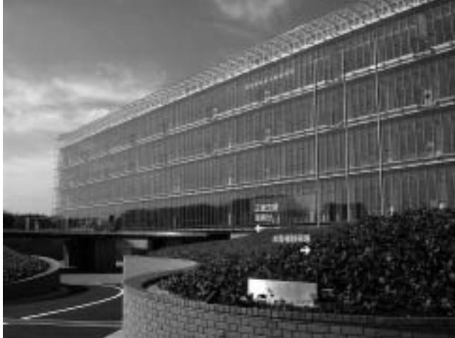
建物外観（南側・エントランス）
