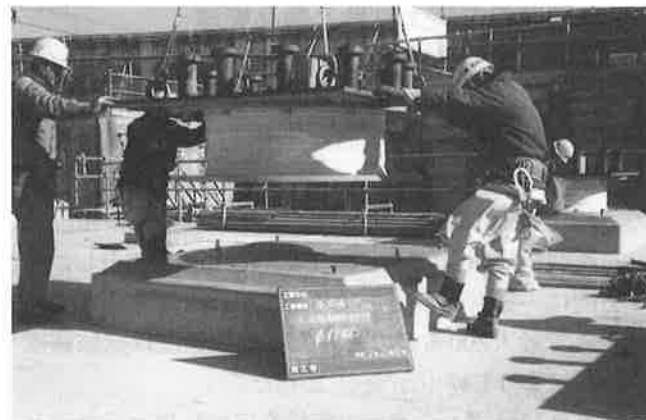
写真-1 免震装置の取り付け
