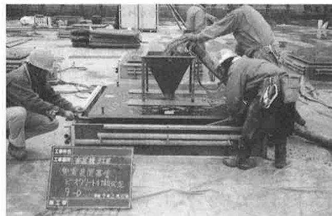
写真-2 免震装置の基壇コンクリート打設
