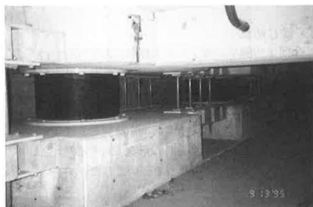
写真-3 ゴム支承と鋼棒ダンパー ゴム支承は直径756mm、高さ406mm 鋼棒ダンパーは直径32mm、8本で一組
