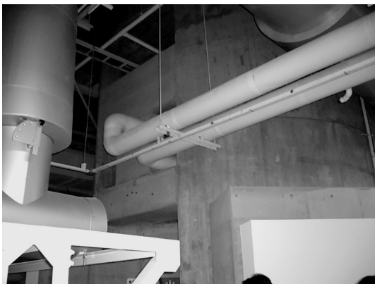
写真11 盛替後の設備配管 その2
