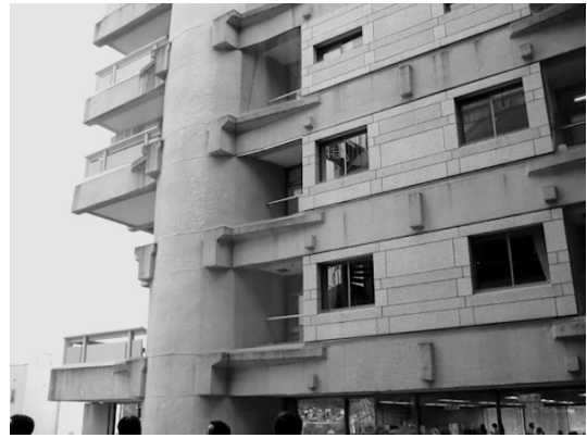
写真16 コア柱と梁の外観 その1
