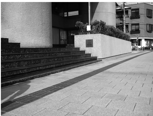
写真12 正面玄関の水平クリアランス状況
