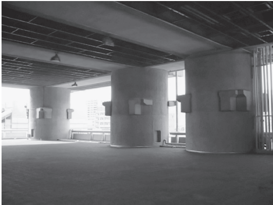
写真18 コア柱と梁の外観 その3
