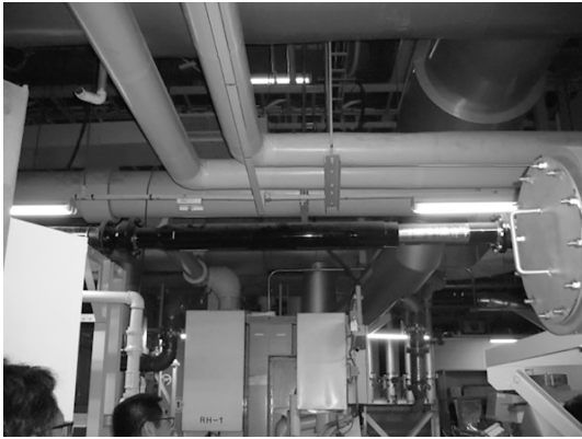
写真10 盛替後の設備配管 その1
