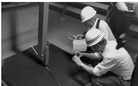
写真2 中央公会堂の罫書き記録の調査 (7月9日実施)
