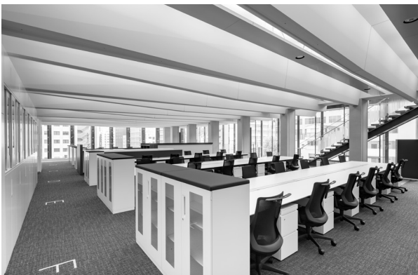
写真2 躯体現しの執務室
