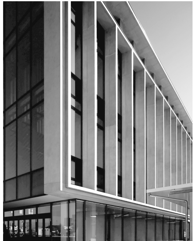
図5 PC縦リブのデザイン
