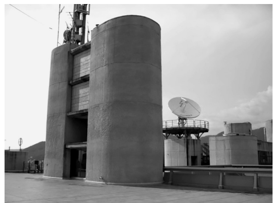
写真15 小叩き仕上げの塔屋
