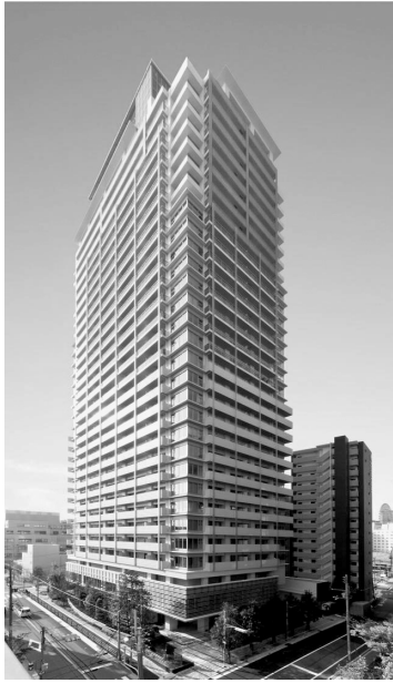
写真3 震度6弱域の超高層免震建物 (RC造31階地下1階：基礎免震)
