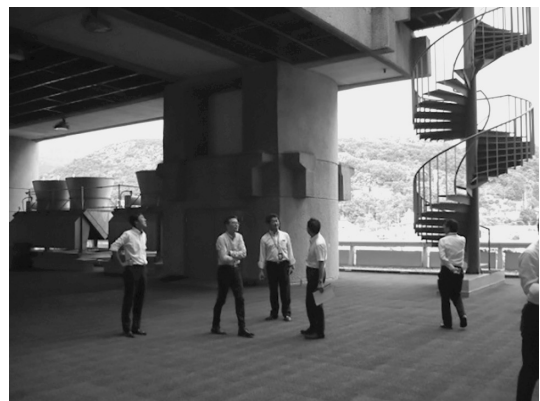
写真17 コア柱と梁の外観 その2
