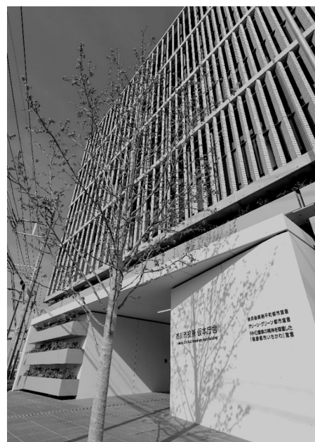
図2 エントランスからの外観
