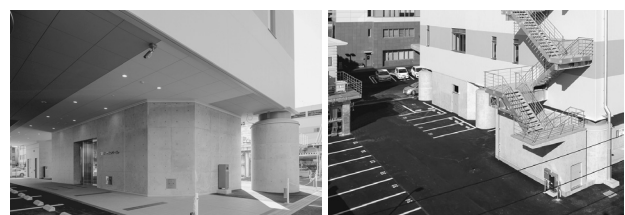
写真4 エントランス廻りRC柱 (基礎躯体から自立)
