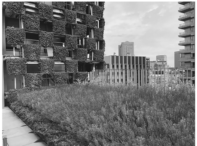
写真5 屋上緑化の様子
