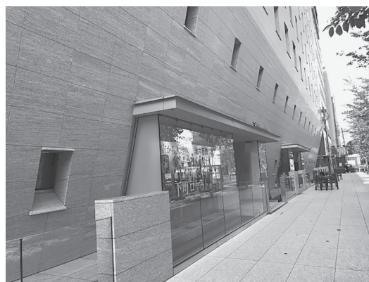
写真2 外部ガラスショーケース
