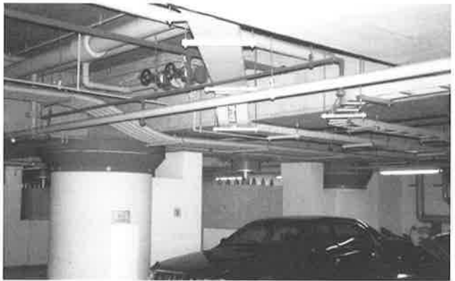
写真-2 免震部材設置状況
