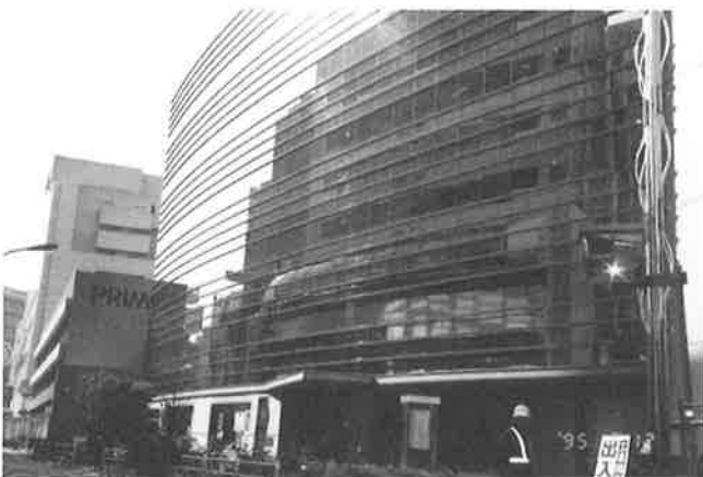
写真-1 東伸24大森ビル外観
