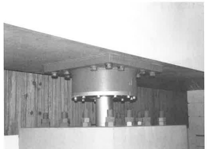
写真-4 鋼棒ダンパー
