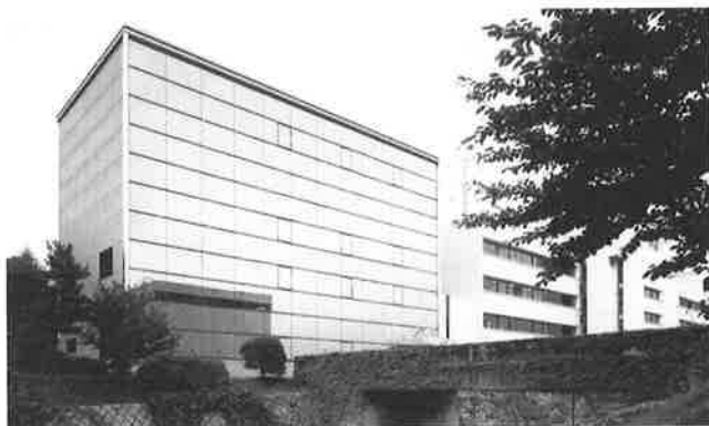
写真-1 建物全景
