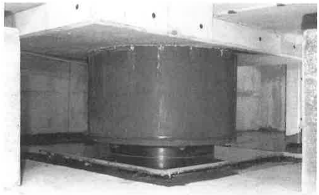
写真-2 すべり支承とすべり板（弾性すべり支承）
