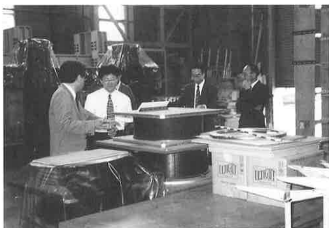
写真-4 実験棟内部
