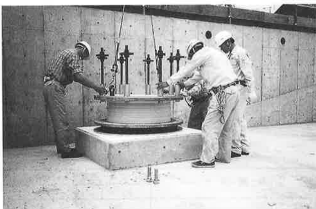
写真-1 施工状況
