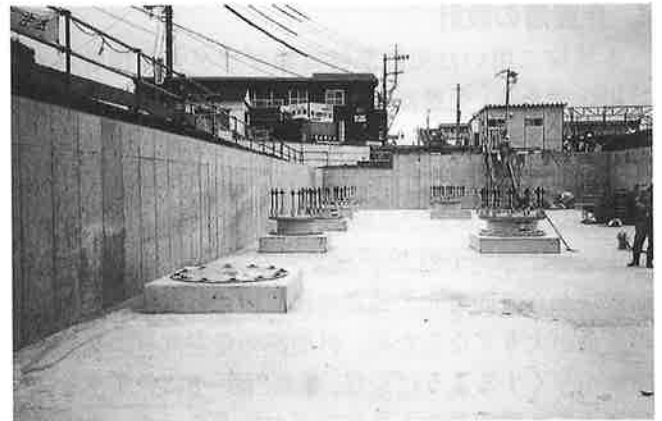
写真-2 免震部材設置状況
