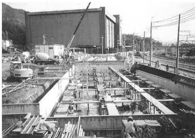
写真-3 C-4棟工事状況
