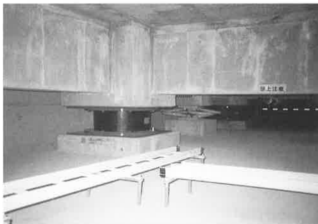
写真-2 A-1棟の免震部材設置状況
