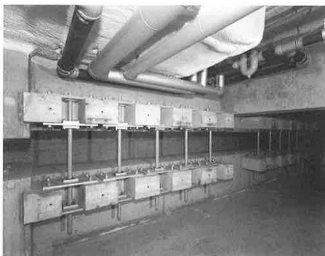
写真-3 鋼棒ダンパー
