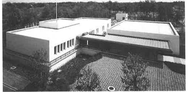
写真-1 無振動特殊実験棟の全景
