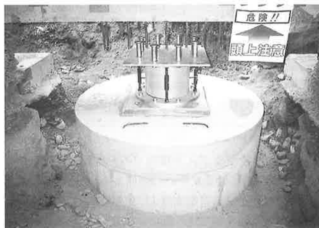
写真-4 免震部材をターンバックル付きボルトで緊張した状態
