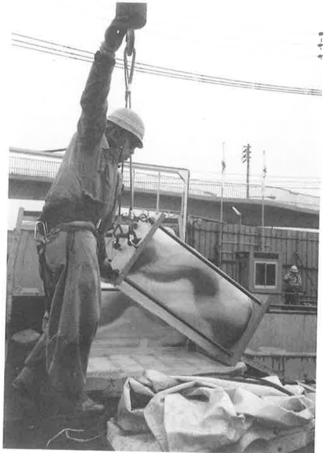
写真-5 吊り上げ作業状況
