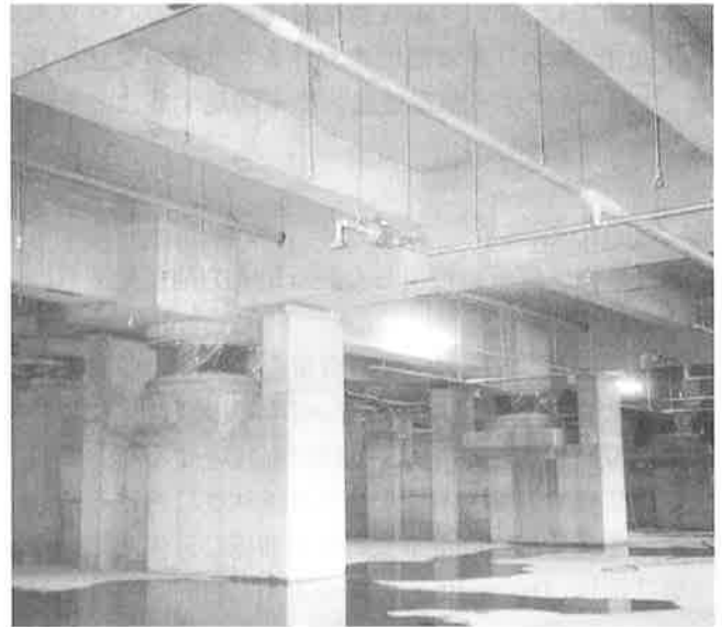
写真-1 免震部材設置状況(A1西棟)
