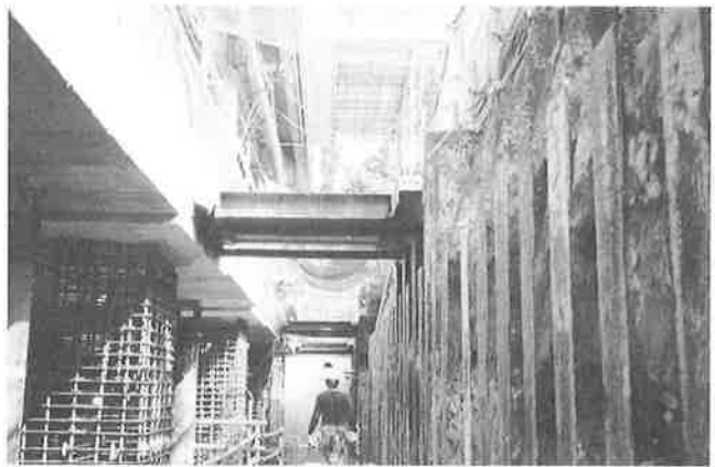
写真-5 建物周辺の鉄骨切り梁
