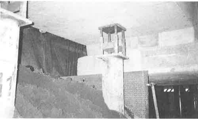
写真-2 鋼管による建物の仮受け
