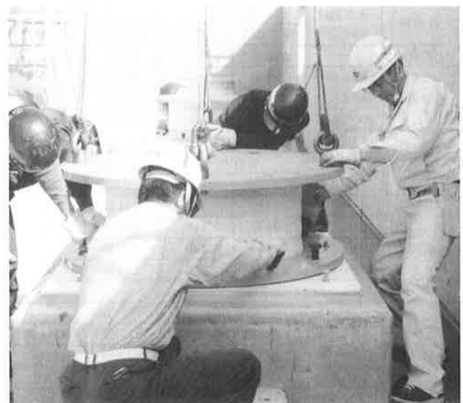
写真-3 免震部材設置状況(A2棟)
