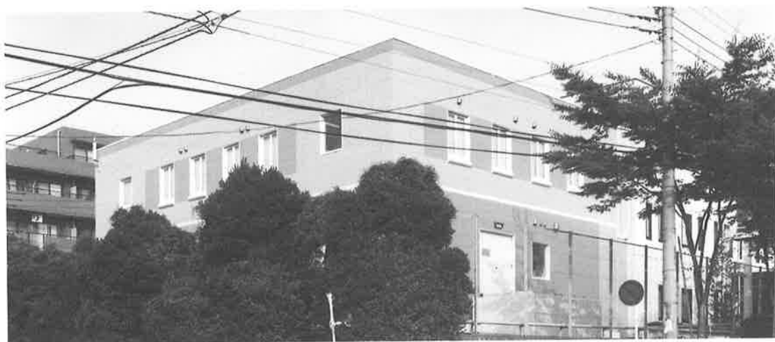
写真-1 建物全景
