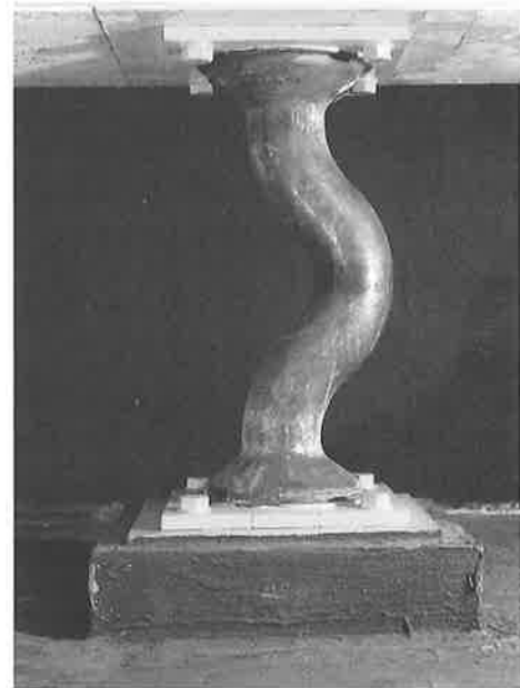
図-5 摩擦ダンパー(他建物での設置例)
