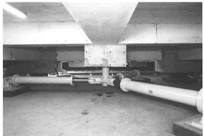
図-5 摩擦ダンパー(他建物での設置例)
