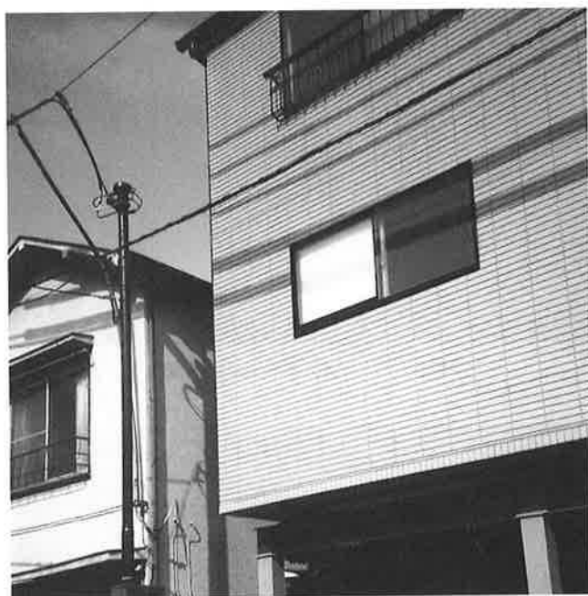
写真-4 引き込み電線の柱
