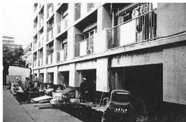
写真-3 既存柱・梁の補強状況(コンクリート打設完了時)
