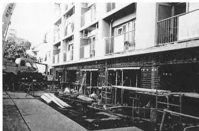
写真-2 既存柱・梁の補強状況(配筋時)
