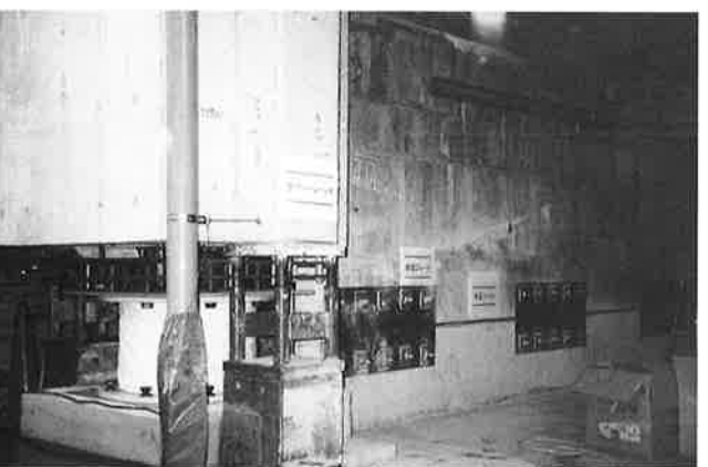
写真-7 仮設耐震プレート設置状況
