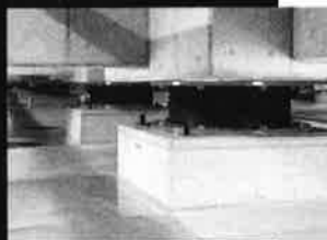
免震装置設置状況 LRB (φ1200)
