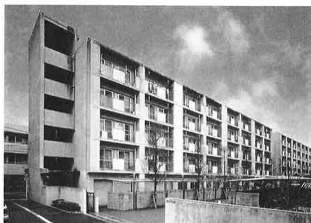
写真-1 改修前の建物外観
